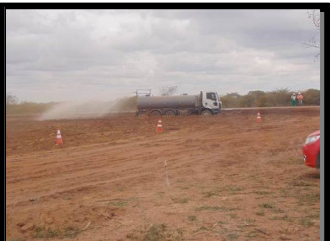
B – Umectação do terreno, exemplo de medida adotada para minimizar a emissão de poeiras.
