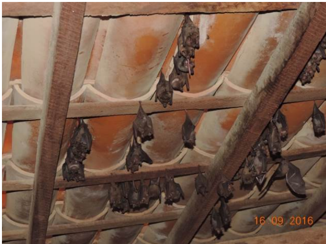
Colônia de morcego-beija-flor ( Glossophaga soricina ) em edificação abandonada na AID do empreendimento, UTM 25M 171069 m E, 9359995 m N.
