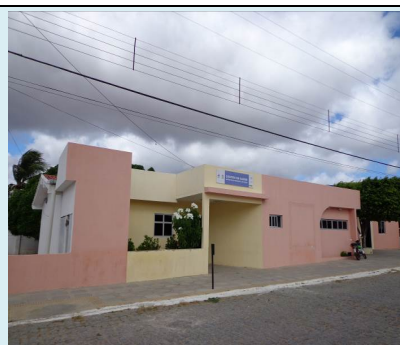
Centro de Saúde na área urbana do município de Caiçara do Rio do Vento.
