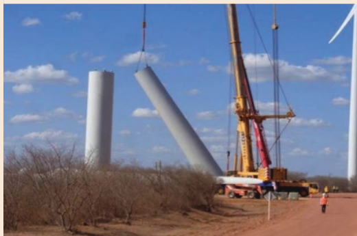
Montagem do segundo seguimento da torre
