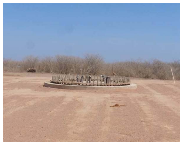
D - Base concretada e terraplanada, pronta para montagem do aerogerador.
