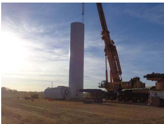
A - Montagem do primeiro seguimento da torre.
