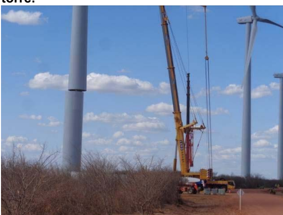
C - Montagem do terceiro seguimento da torre.
