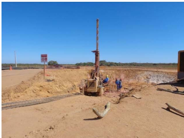
A - Execução de estaca raiz na área da base dos aerogeradores.
