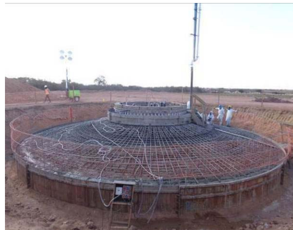
B - Base em processo de concretagem.
