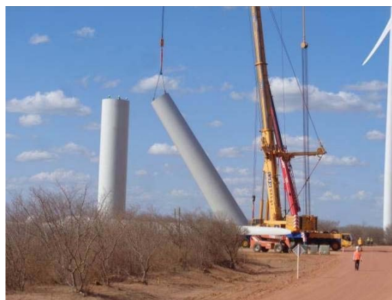
B - Montagem do segundo seguimento da torre.
