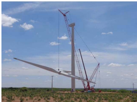
E - Montagem das pás.
