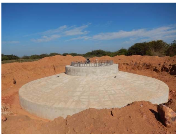
C - Base concretada.
