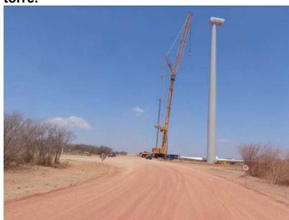
D - Montagem da nacela.
